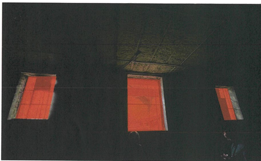
Foto 15. Golurile ferestrelor se vor acoperi cu panouri de OSB acoperite cu folii impermeabile, împănate sau cu spumă. Acestea se vor monta în golul de fereastră. În vederea asigurării stabilității, golurile mai mari vor fi bordate cu un cadru de lemn pe care se vor prinde ulterior OSB-urile protejate cu folie.
