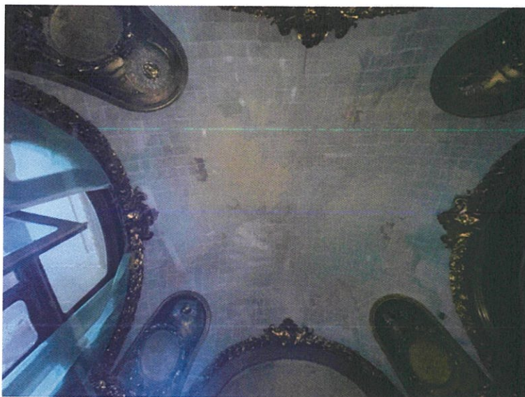
Foto 01 - În vederea protecției suprafețelor picturale se va păstra foița japoneză.
