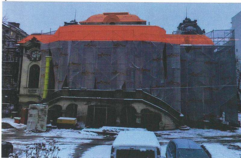
Foto 13. Se va menține schela exterioară metalică, în vederea montării materialelor de protecție ale învelitorilor. Ulterior se va demonta.
